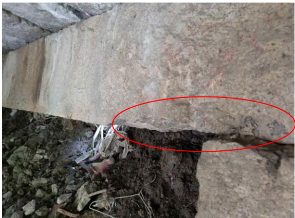
图 3.2.1.1-1 1-2#主梁底面剥落掉块
