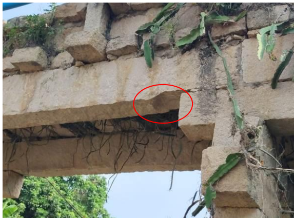
图 3.2.1-2 4-2#主梁底面剥落掉块
