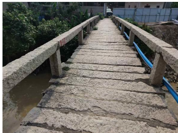
图 3.1.1-2 桥面铺装条石灰缝局部存在缺失
