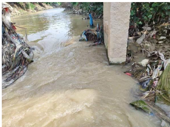
图 3.3.3-1 3#墩基础冲刷
