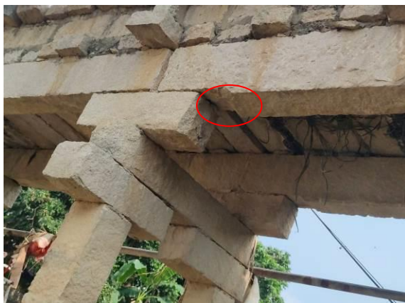
图 3.2.1-3 4-2#主梁底面剥落掉块
