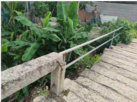
图 3.1.5-1 栏杆局部钢管修补，高度不满足规范
