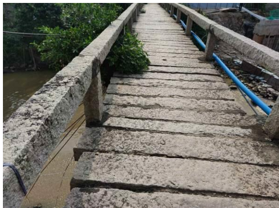
图 3.1.1-1 桥面铺装条石灰缝局部存在缺失
