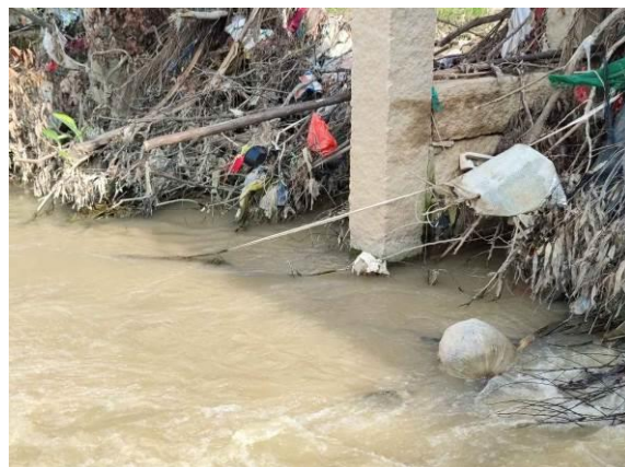
图 3.3.3-2 4#墩基础冲刷
