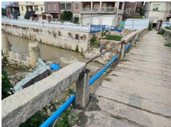
图 3.1.5-2 栏杆局部钢管修补，高度不满足规范
